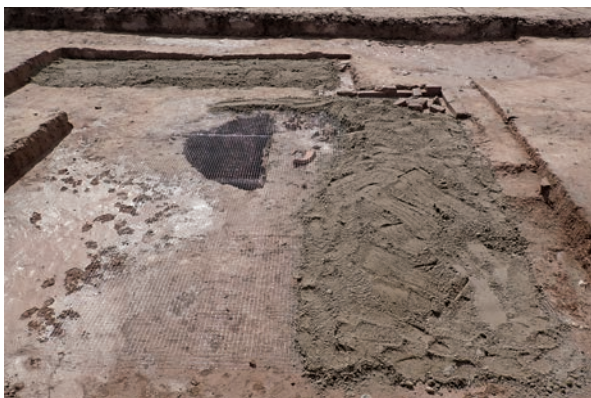
Fig.4.37 花柄の石敷き付近 砂による埋め戻し状況
