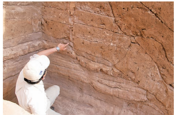
Fig.11.6 城壁断面に見える地滑りの痕跡
