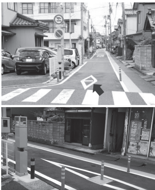
Fig.11 ライジングボラード作動前（上図）と、 作動後（下図）
